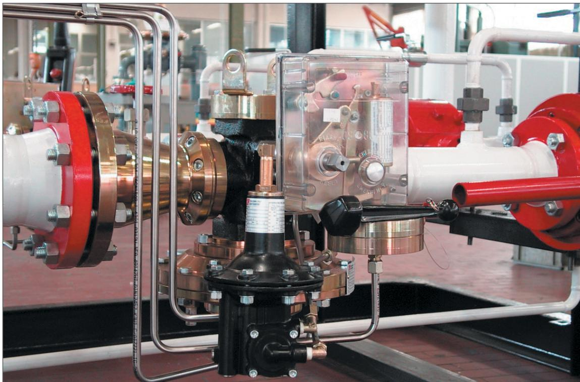
Dettaglio Gruppo di Regolazione con CB-SRS. Flusso Gas da Destra a Sinistra
